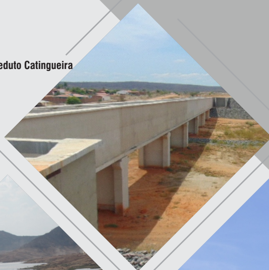
Reservatório Boa Vista
